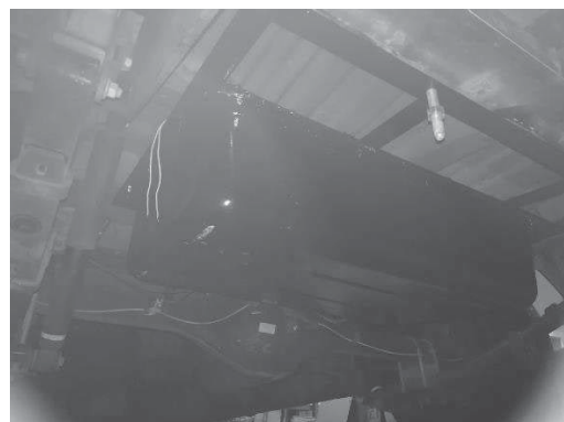
燃料タンク施工写真（後方より）
