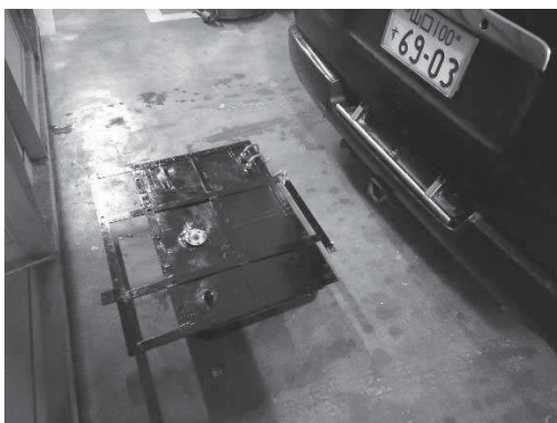
燃料タンク施工写真
